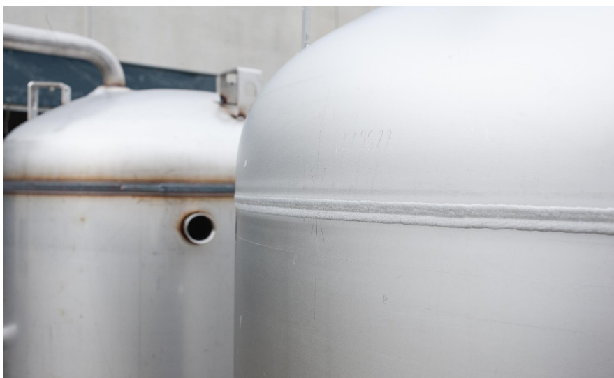
Comparaison entre deux réservoirs, l'arrière avant le traitement, l'avant après le traitement
